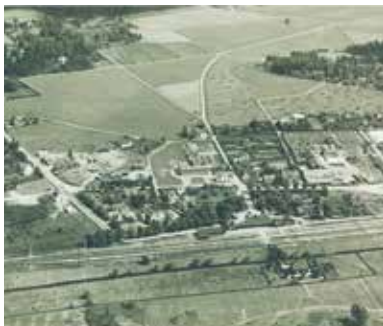
Vy över stationsområdet år 1936. På bilden syns bebyggelsen i järnvägsparken till vänster. Den centrala vägen (idag Centralvägen) leder till stationen som syns i mitten av bilden.
