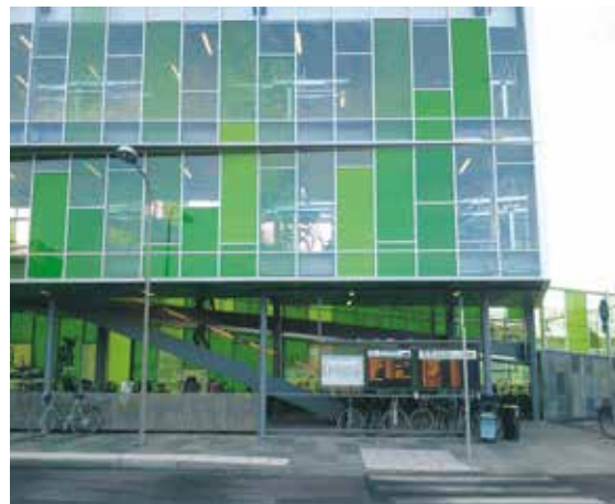
Cykelgarage i Älvsjö resecentrum.
