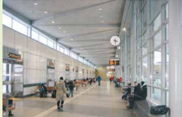
Referens: Jakobsberg bussterminal. Exempel på en docknings-terminal med inbyggd vänthall med dubbel takhöjd och stora ljusinsläpp mot gatan. Terminalbyggnaden har elva stycken dockningslägen och är cirka 150 meter lång.
