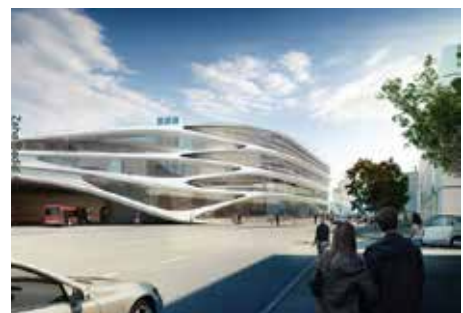
Byggprojekt: Väsbys Entré/Stationsområdet
