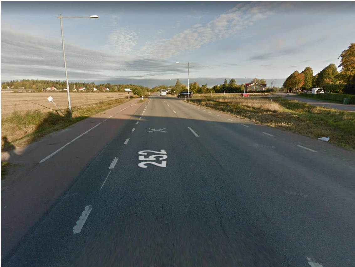
Figur 24: Hållplats söder om Hallstahammar utan övergångsställe: Bildkälla: Google maps (hämtad 2021-02-01).
