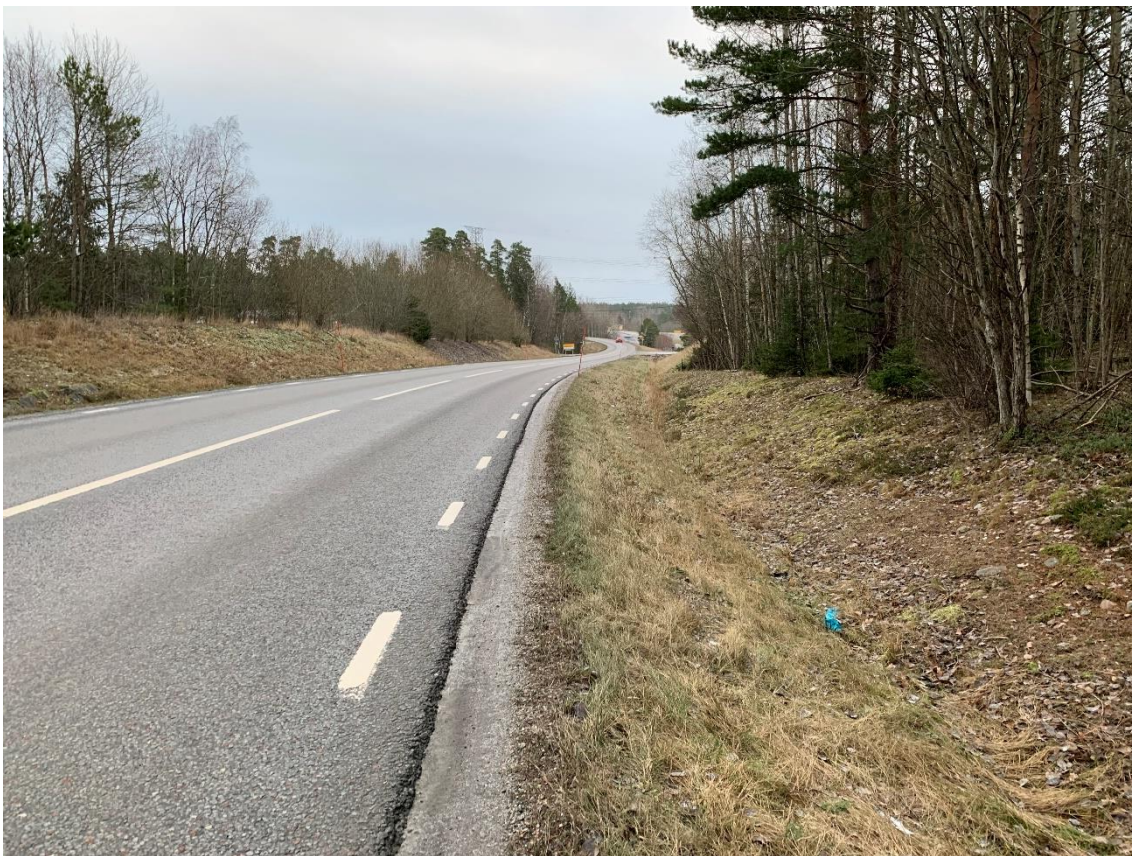
Figur 4: Ont om utrymme vid sidan av vägen för gående och cyklister.
