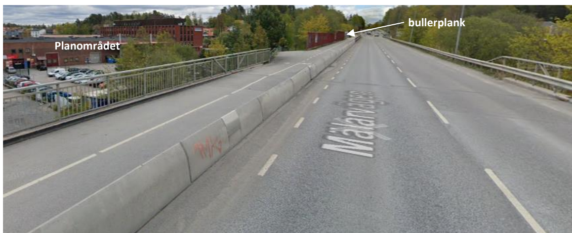
Figur 5. Mälärvägen vy mot öster. (källa: Google maps)
