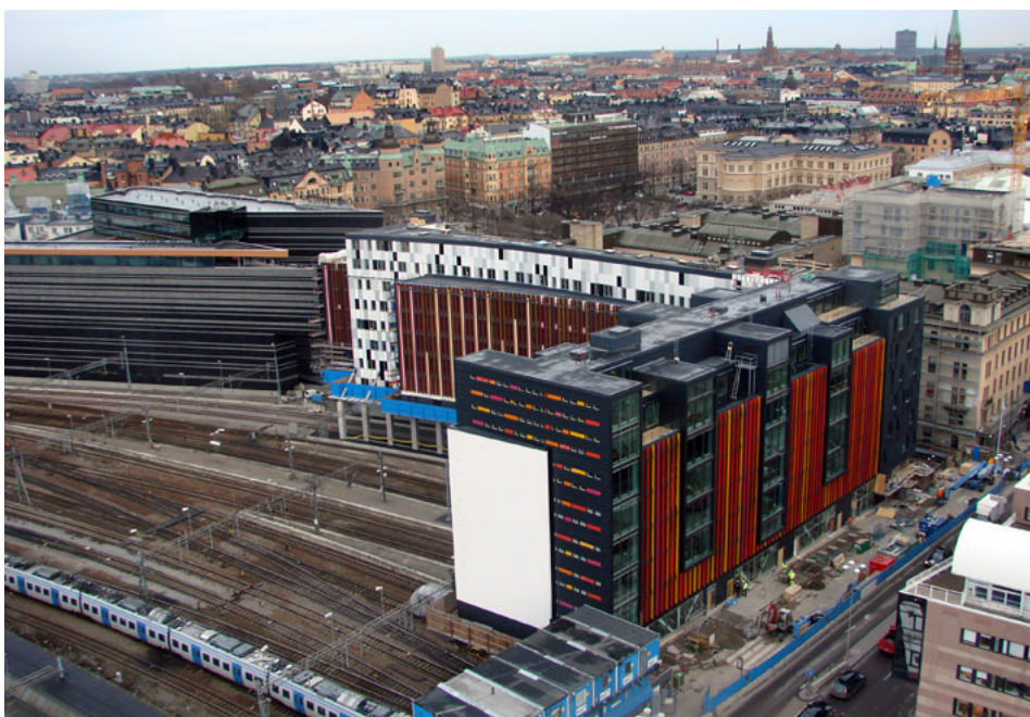
Figur 4.1. Huset som ligger över spåren samt det sammanbyggda huset längs med spåren har magnetfältreduktion med passiv skärmning.
