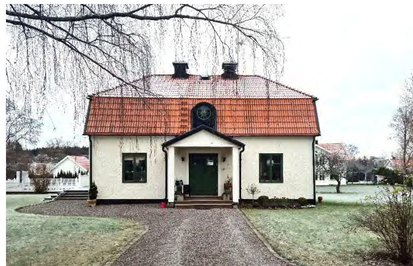
Bostadshuset sett rakt söderifrån.
