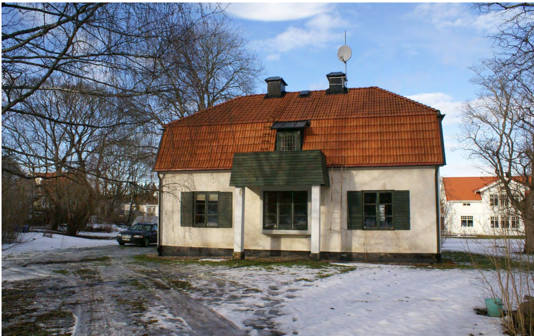
Vita flygeln under tidigt 2000-tal, innan byggnaden genomgick den senaste upprustningen. Norr om byggnaden och till höger i bild ligger en av de villor som uppfördes i början av 2000-talet, på mark som tidigare hörde till Grimsta 5:125. Foto och källa: Roland Storm.
