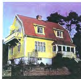
Bibehåll ursprungligt fasadmaterial även vid tilläggsisolering. Måla med en för hustypen tidstypisk färgkaraktär. Använd oljefärg. Studera anslutningar till fönster, taksprång och takkupor.
