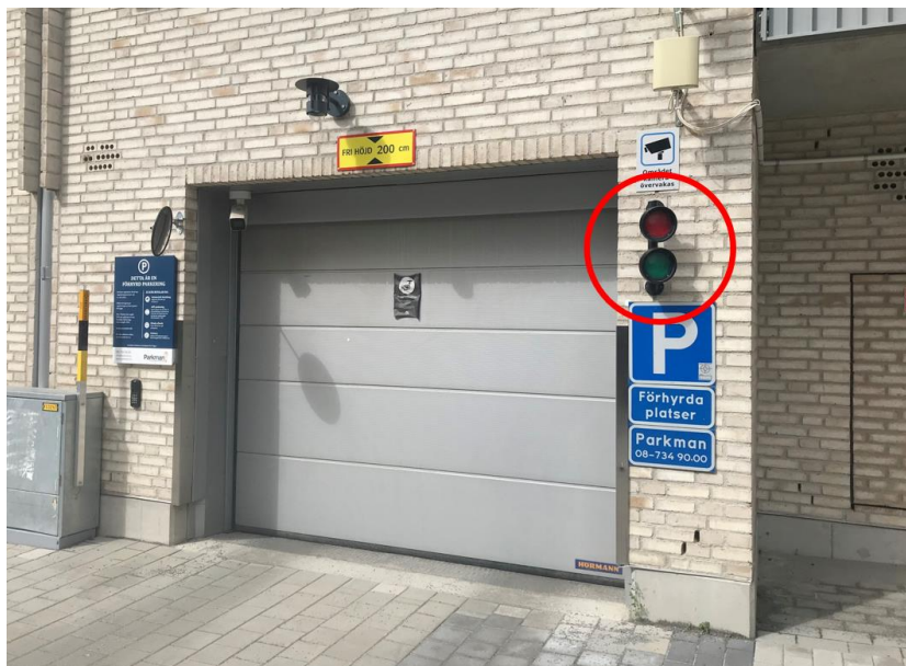
Figur 27. Exempel på signallösning med grön/röd signal bör användas vid garageporten där uppsikten av garagerampen är begränsad. Bildkälla: WSP.
