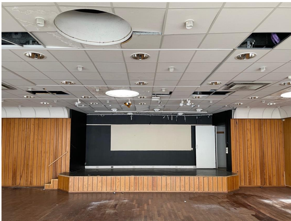
Danslokalen på övervåningen med centralt placerad scen och panelbeklädda väggar.
