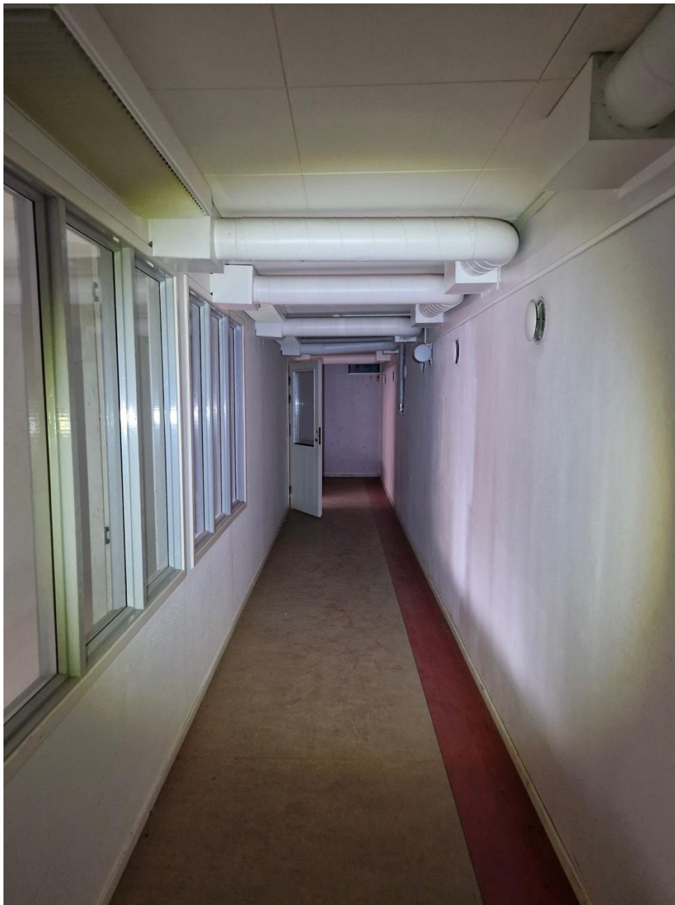
Källarkorridor i östra delen av byggnaden, belägen under scenen. Utrymmena i denna del av källaren bär spår av relativt sentida förändringar. Foto: AB Väsbyhem.
