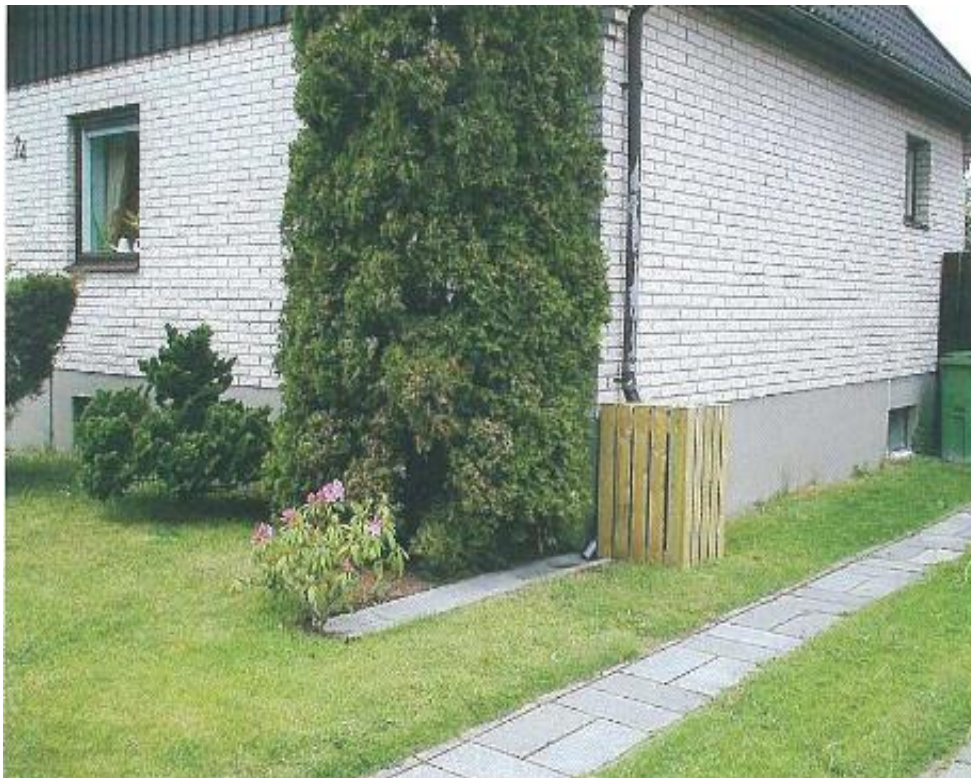
Figur 18 Avledning av takdagvatten till en infiltrationsyta (Källa: Värmdö kommun).
