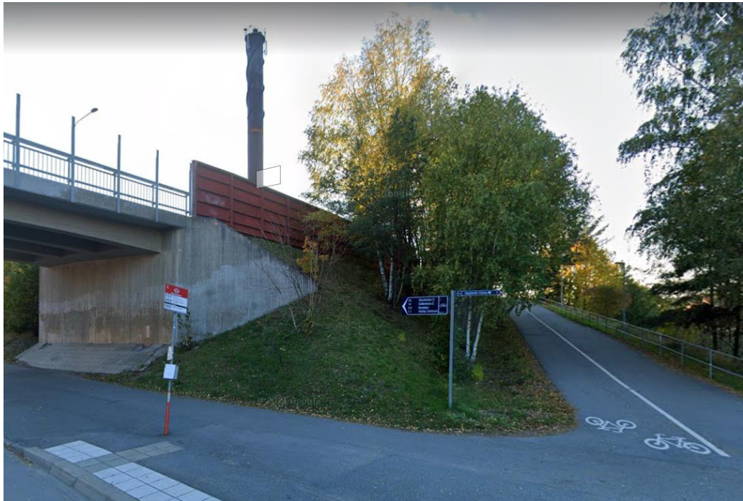
Figur 9. Befintlig GC-väg vid Optimusvägen / Mälarvägen,
