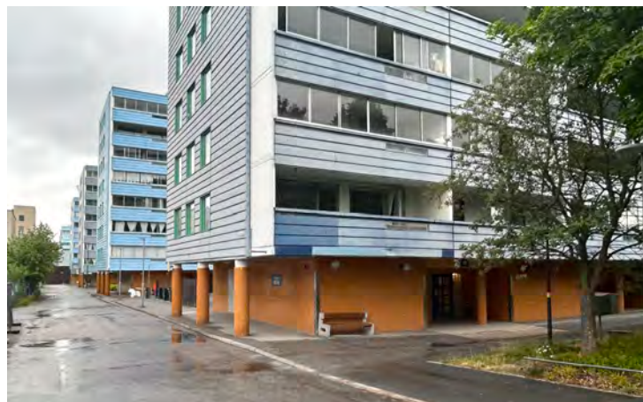
Skivhusen möter ett bilfritt gångstråk i väster. Sockelvåning med gult glaserat kakel och kakelklädda pelargångar.
