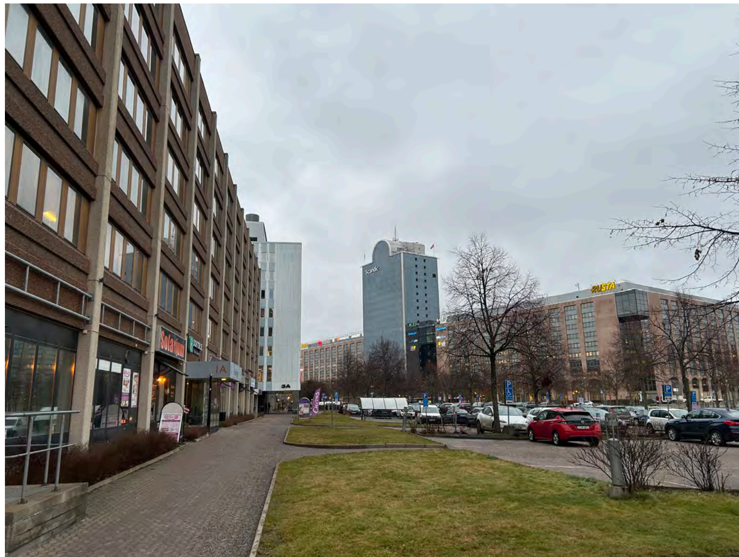
Framför ett äldre kontorshus med lokaler i bottenvåningen finns anlagda parkytor med trädtrader, sittplatser och parkering inordnad i halvcirkelform. Den högre mittdelen har vit och ljut blå plåtfasad som kontrasterar mot de sidoplacerade volymernas mörkbruna fasader med grå betongpartier.
