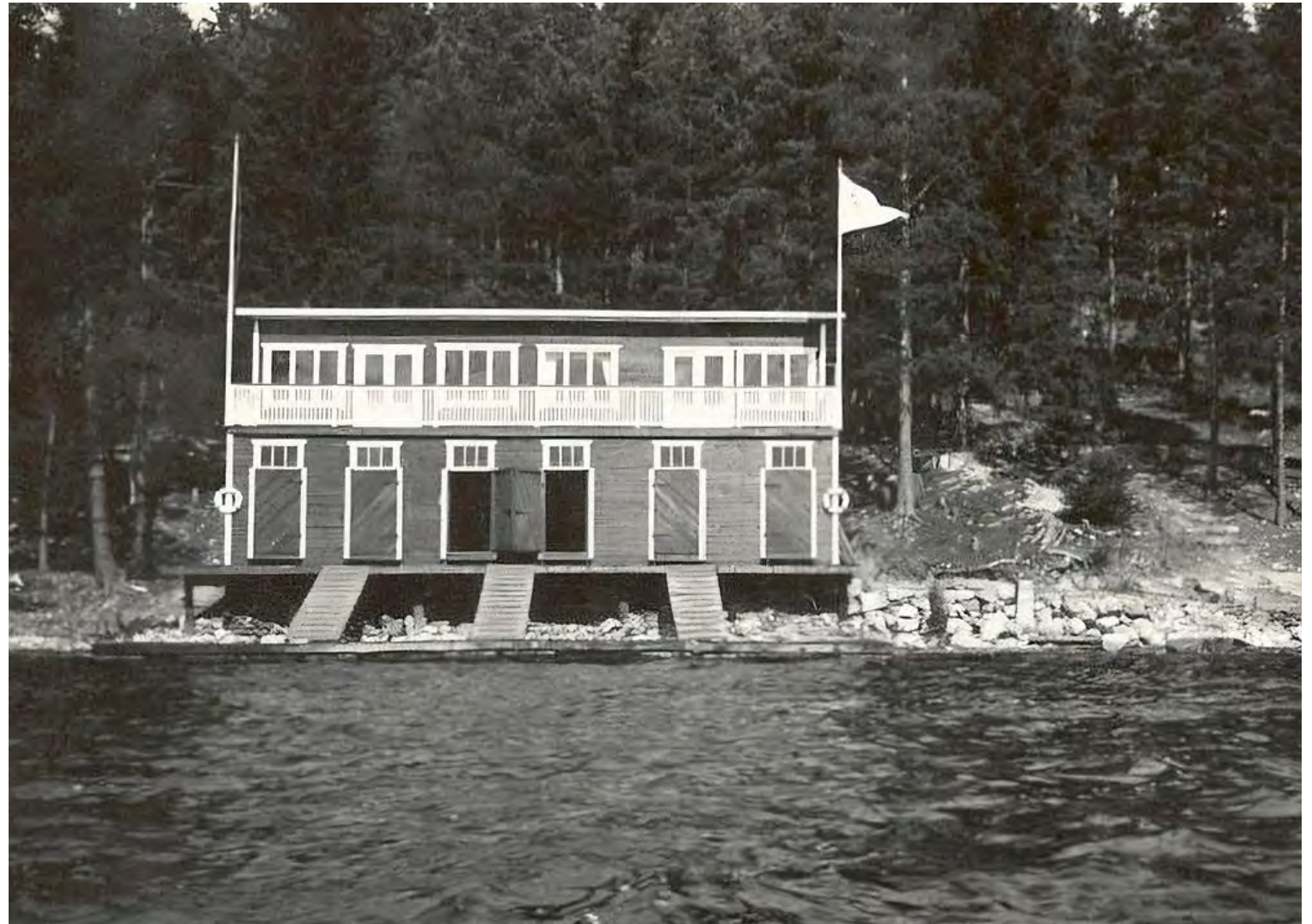
Kanotklubben Glids kanothus. Nuvarande kanothus byggdes 1936-38 och är arkitektritad. Det ser i princip likadant ut idag. Källa: Kanotklubben Glid
