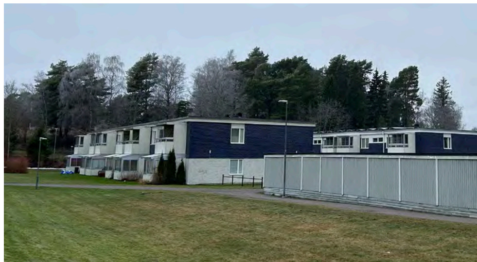
Fasad i vit spritputs med övervåning i färgstarkt glaserat holländskt fasadtegel. Garagelängor i trä.
