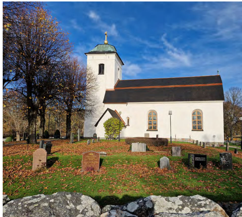
Eds kyrka uppfördes ursprungligen som en romansk sockenkyrka i slutet av 1100-talet och präglas idag av 1700-tal. I förgrunden en del av den äldsta delen av kyrkogården och bogårdsmuren.
