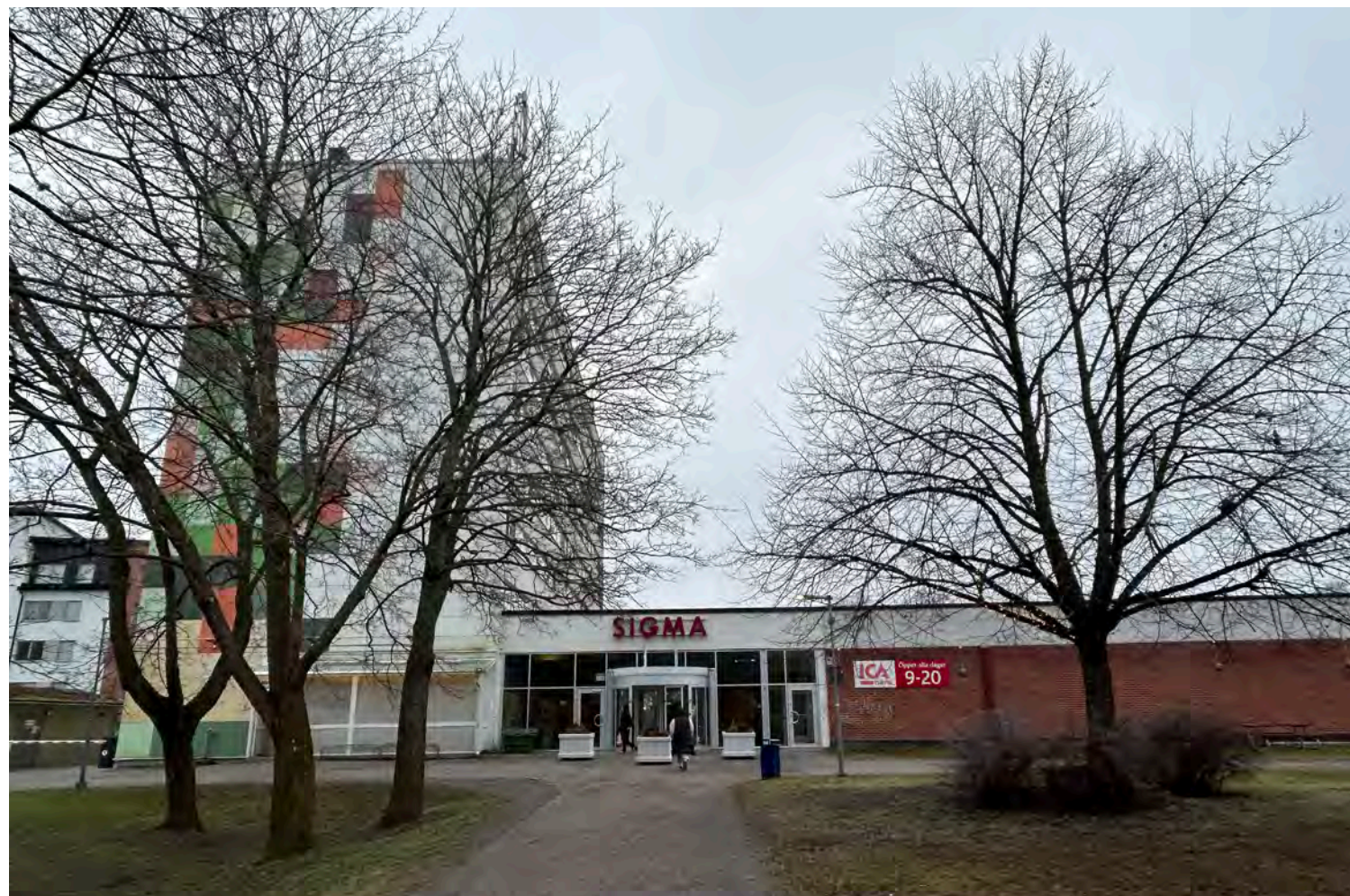
Sigma centrum, typiskt modernistiskt sammanbyggt lågdel och högdel med gavel som annonserar centrum mot parken. Genom hela kvarteret går sammankopplande gångstråk från bostadsgårdarna genom parken fram till centrum.
