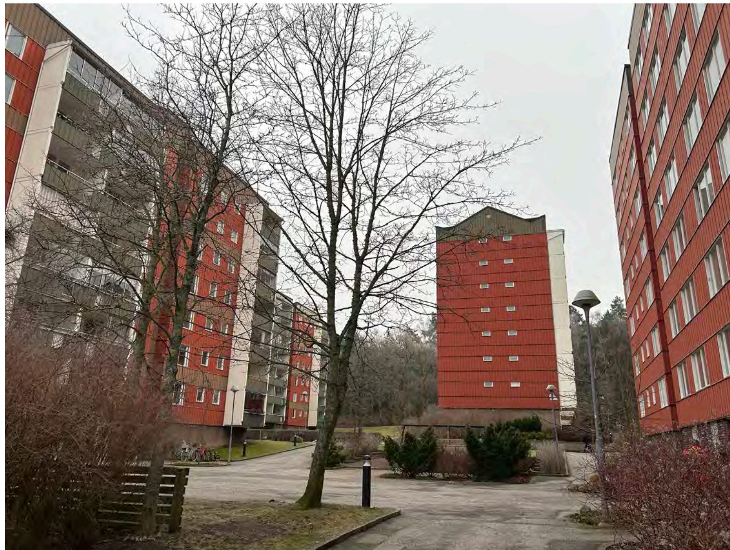
Parallellställda skivhus vid Stallgatan med karaktäristisk gavelsiluett. Husen har fasader i brun- och rödmålad plåt i kombination med en hög sluten sockel i mörk puts och tegel. Mellan husen finns bilfria bostadsgårdar som med en skarp gräns möter Smedbyskogens natur.
