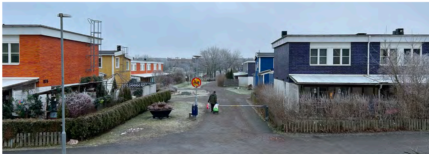
Två kvarter avdelade av ett mellanliggande gångstråk. Längorna som ramar in kvarteren är utförda i vit spritputs och glaserat fasadtegel, lika Smedby 1.
