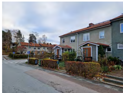
Tillbygda entréer mot Lagmansvägen.
