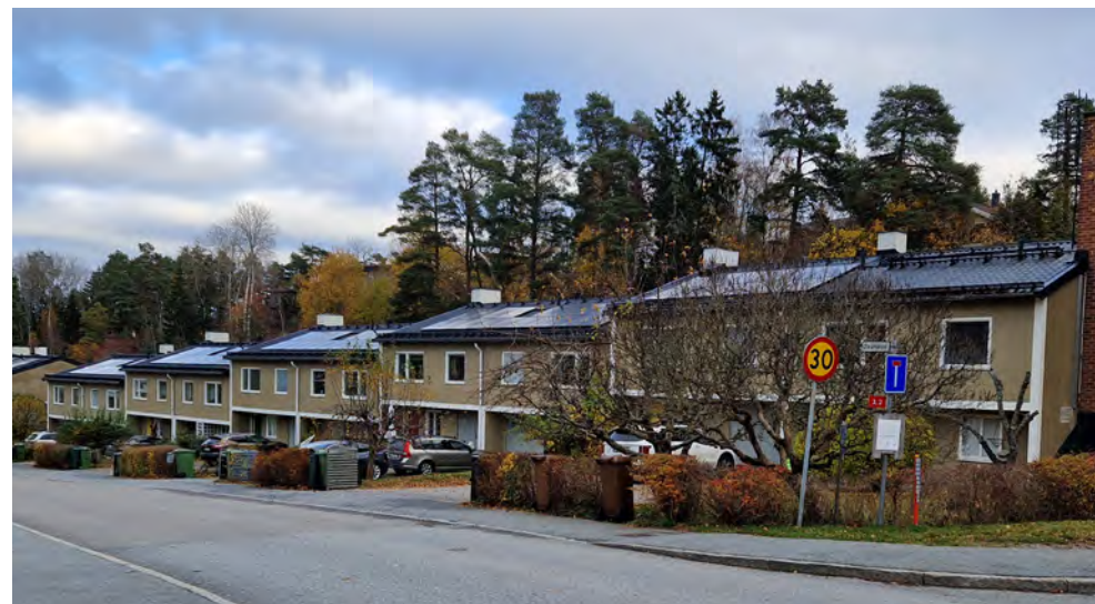
Radhus i suterräng följer terrängen och trappar ner längs gatan. Indragna entréer och garage i bottenvåningen.
