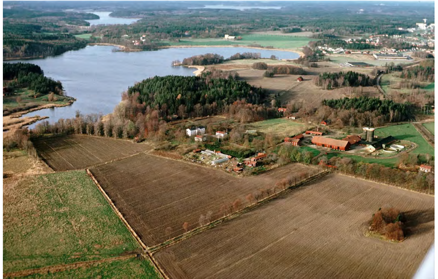
Flygfoto över Antuna och Edsjön. Herrgården i vit puts syns till vänster i bild. Till höger och i anslutning till bakomliggande skogspartier syns ekonomibyggnader i färgad panel, omgivna av hagmarker. Odlingssmarken består av stora sammanhängande åkermarker med några mindre åkerholmar. Angöringsvägar med alléer leder rakt över åkrarna mot gården från söder och öster. Järnvägen skär tvärs genom landskapet till höger i bild.
