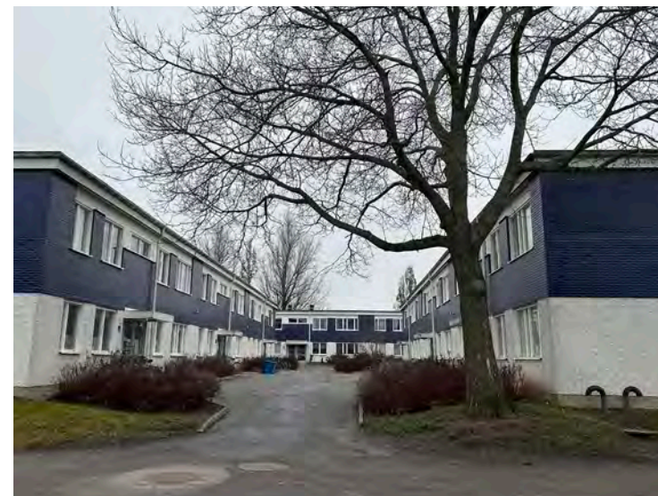
Entréerna ligger vända mot en gemensam entrésida.
