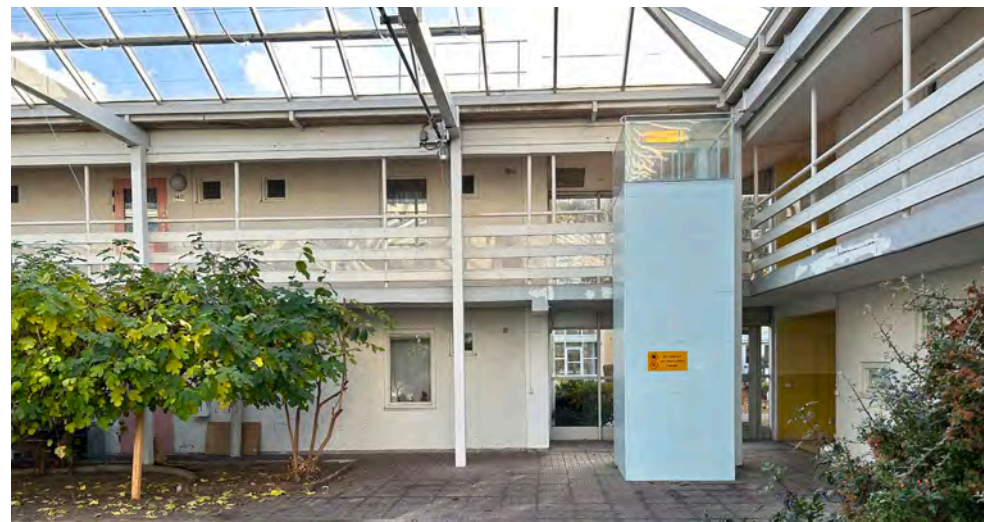
Invändig atriumgård med loftgångar till bostadsentréerna, gemensamhetsyta och planteringar.
