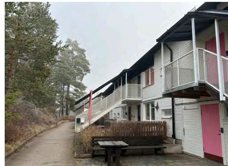
Bostadsentréer via trapplopp med tak mot bostadsgården.
