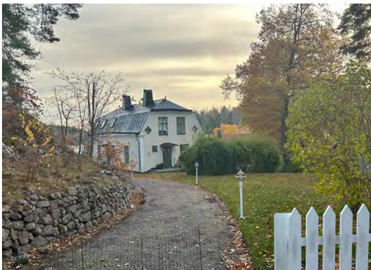
Exempel på äldre villa med putsad fasad och valmat tak i stram klassicistisk arkitektur.
