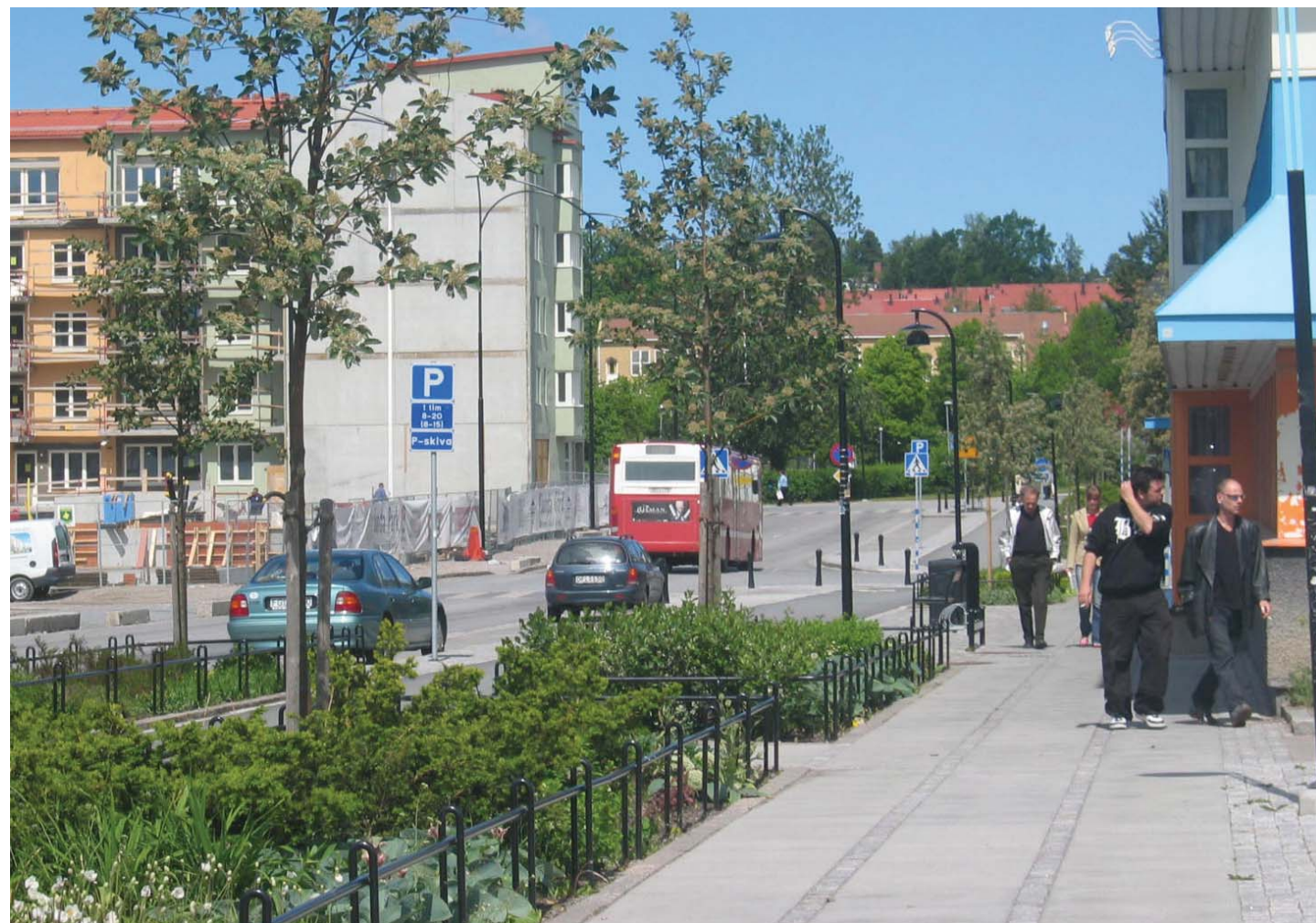
Dragonvägen sett från Väsby Centrum mot Centralvägen med nybyggda hus.
