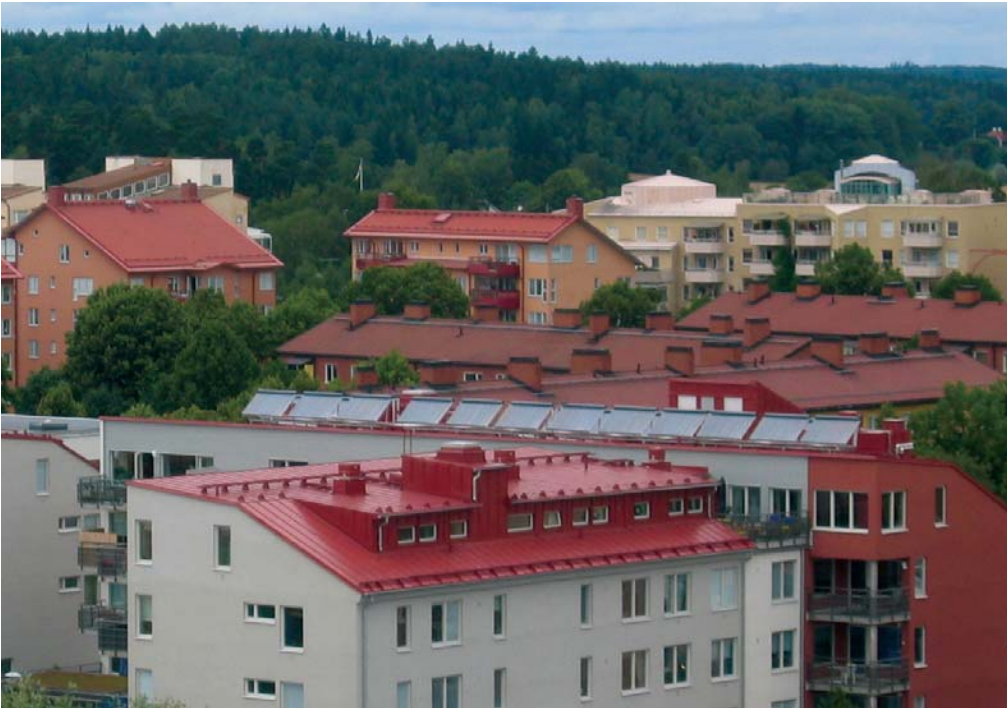
Solfångare på taket till Väsbyhems nya hyresfastighet på Centralvägen.
