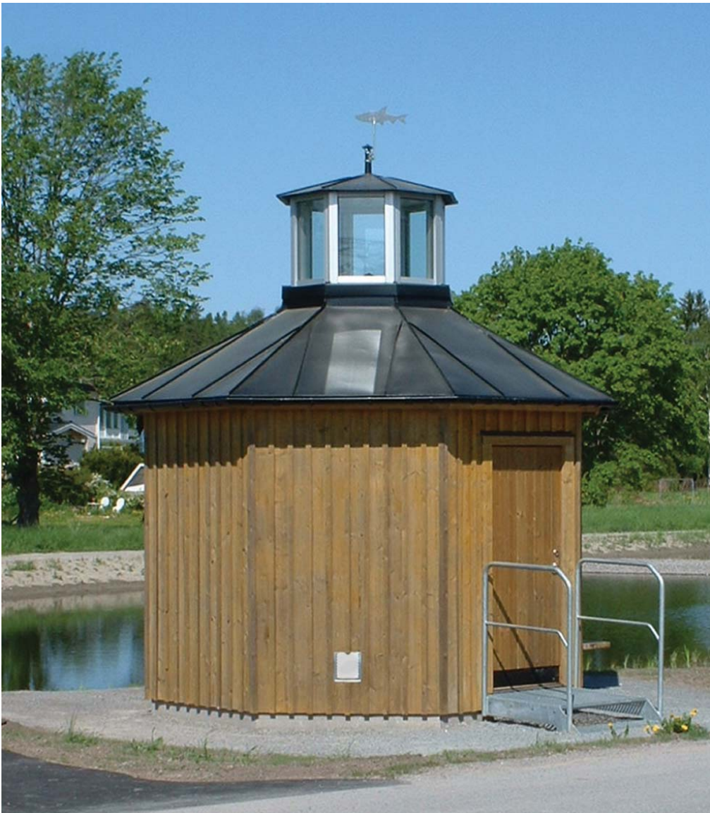
Pumphuset vid Ladbrodammen.
